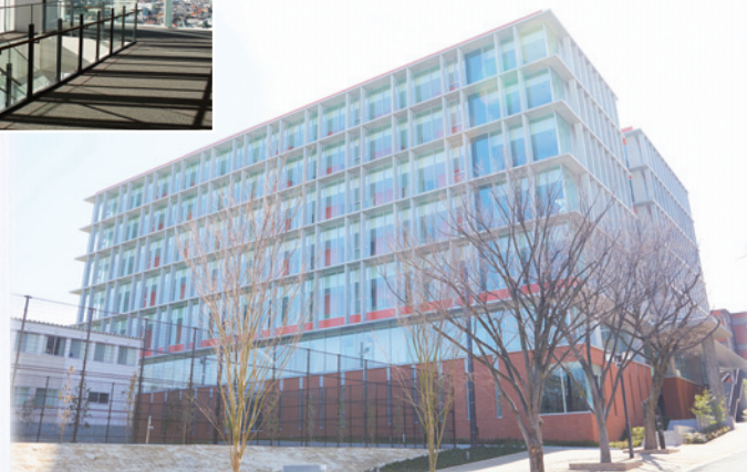
Q棟外観（北側から撮影）
